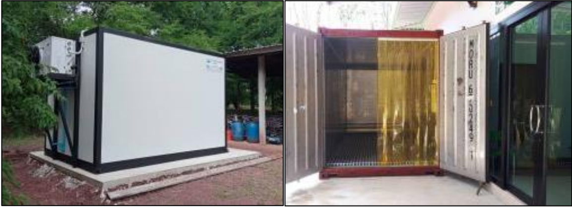
ภาพที่ 24 ห้องเย็นสำเร็จรูปขนาดเล็กใช้เก็บซากสัตว์
